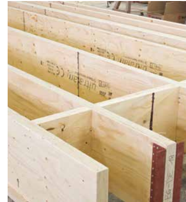
Eksempel på bjelkelagskonstruksjoner med Hunton Finerbjelken.
