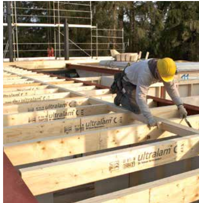
Eksempel på bjelkelagskonstruksjoner med Hunton Finerbjelken.
