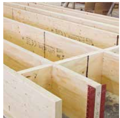
Eksempel på bjelkelagskonstruksjoner med Hunton Finerbjelken.
