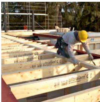
Eksempel på bjelkelagskonstruksjoner med Hunton Finerbjelken.
